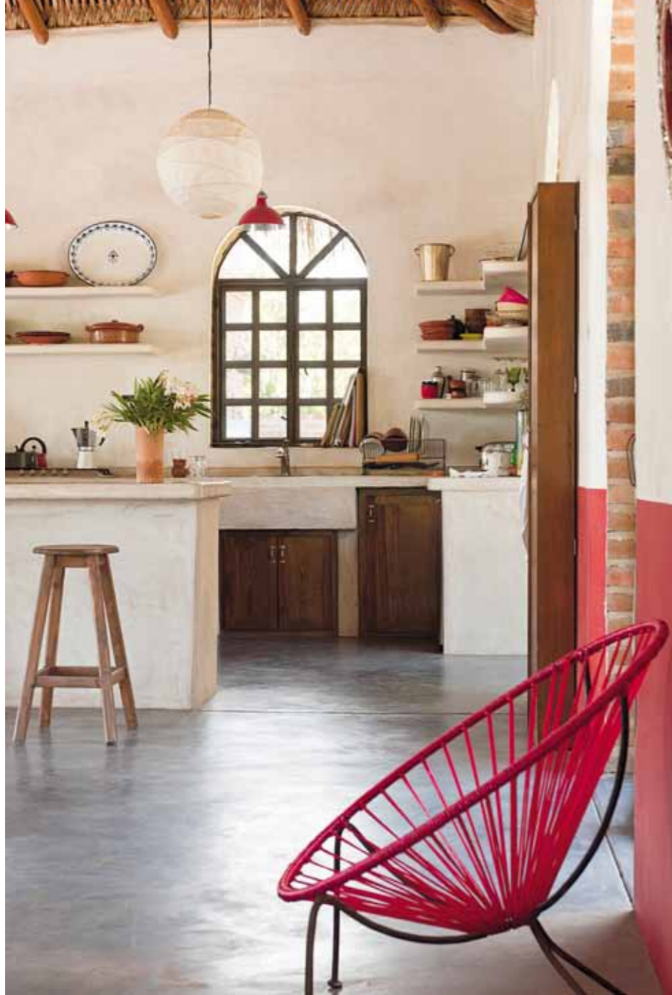
Kontraste zwischen den Materialien beleben die Szenerie. Am Boden des Küchen- und Wohnhauses hat die Gestalterin Betonstrich gießen und polieren lassen. Auch die Theke und Einbauten sind aus Beton – als moderner Gegensatz zu massiven Holztüren und dem kunstvoll geflochtenen Palmendach, das im trockenen Klima erst nach 20 Jahren erneuert werden muss.
